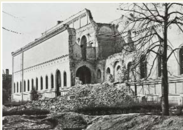
Die Neue Pinakothek nach den Kriegszerstörungen, Fotografie, um 1945
